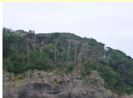
日出島の西面、塩害で枯損した樹木や林床植生
