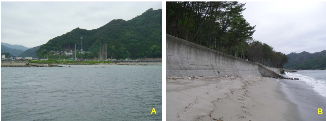
図 2-1-14 海岸変化の事例 2 : 岩手県大槌町波板 (現地写真 : 2012. 6. 13)
