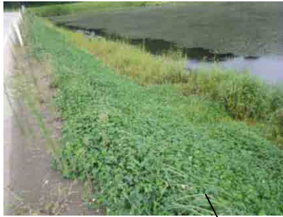
道路法面 (シロツメクサ群落)
