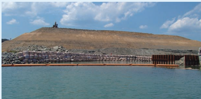
復興工事の様子(宮城県 志津川湾、2015年7月)
