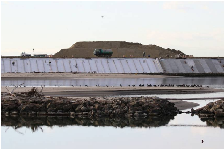
写真:22 護岸工事とコクガンの群れ。休息 行動が見られ、工事の影響はなか った。 (H28. 1. 9)
