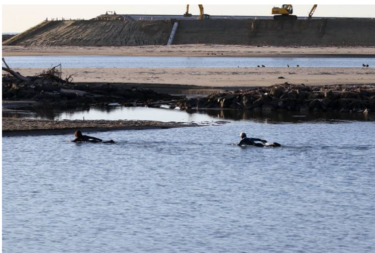
写真:15 導流堤の北側を泳いで渡り海岸に移動するサーファー。コクガンの警戒行動はなかった。 (H28. 1. 9)
