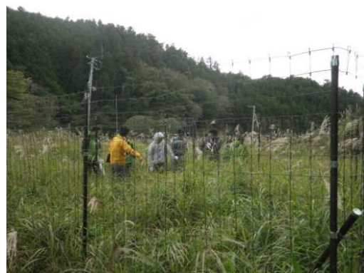
現地に設置されているシカ侵入防止柵
