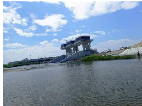
中田川合流部で建設中の水門。水門の奥が中田川。水門手前が B1 地点
