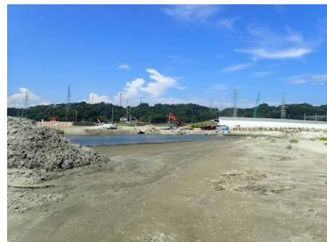
A2 地点付近からみた A1 地点。防潮堤の拡張・沖出し工事が進んでいる。
