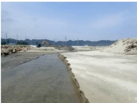
ラグーン部と海への開口部を繋ぐ水路。2015 年以前と比べ海水の流入が少なくなっている。
