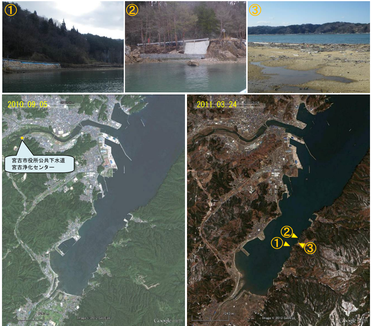
図 4-2 震災前後の比較（空中写真）と被災状況〔宮古湾〕
