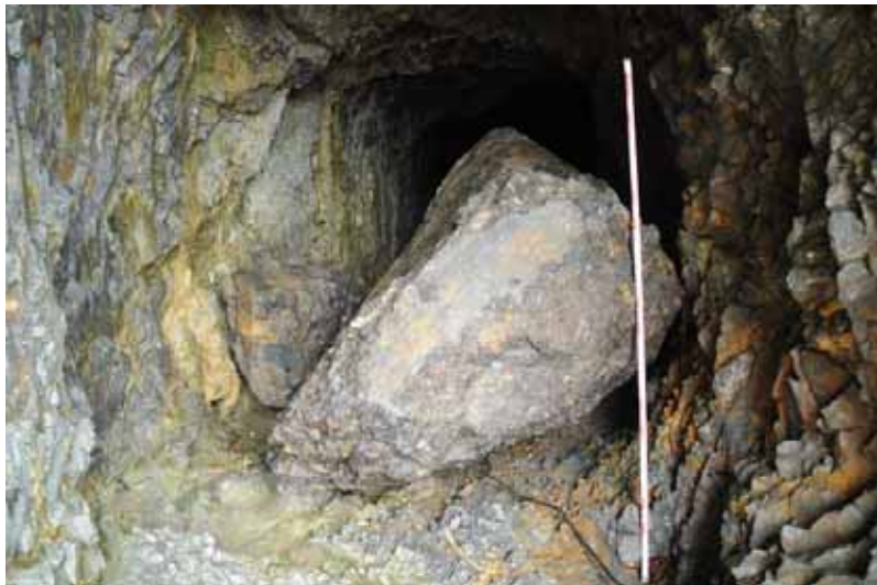
隧道内の津波岩
