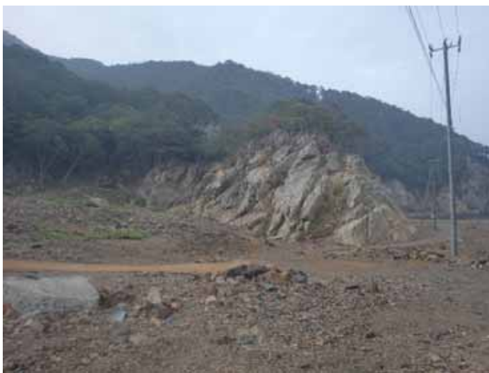
植生・土壌が剥ぎ取られた痕跡
