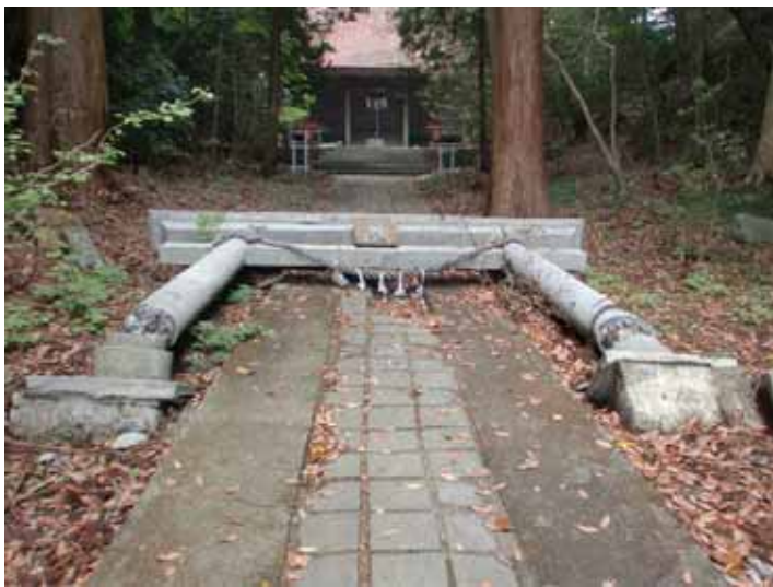
津波により倒された荒神社の鳥居
