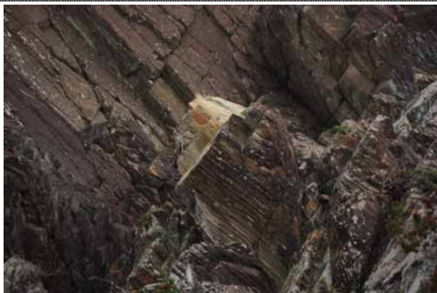
岩壁の崩壊部分
