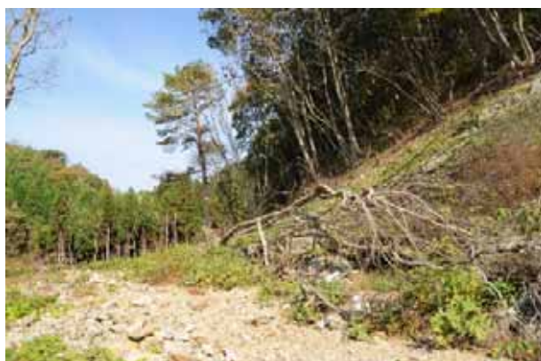
北部の谷入口付近
