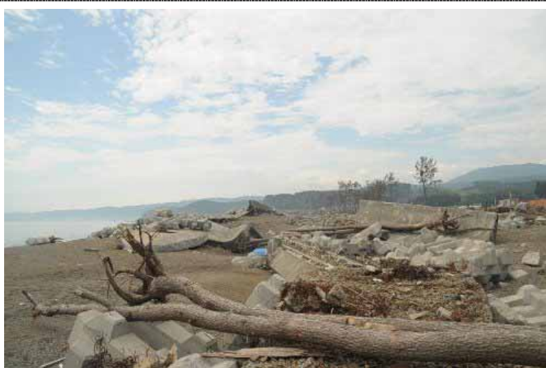
壊滅した堤防と松林
