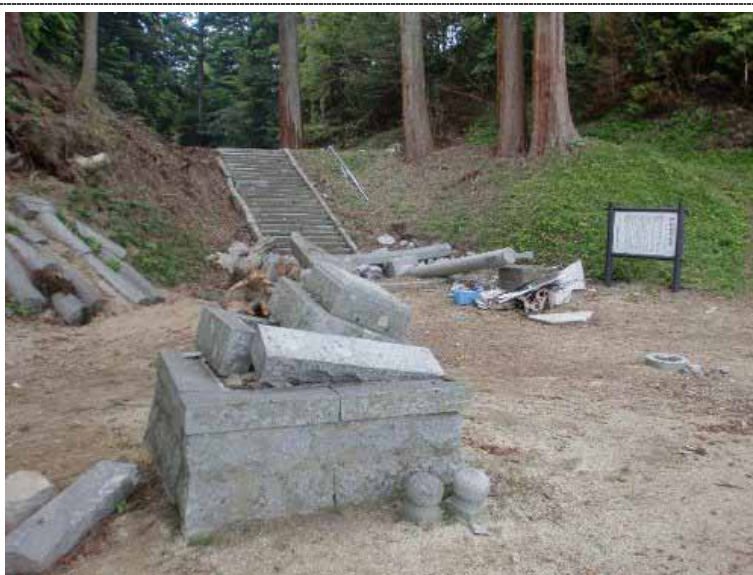
破壊された神社の入口
