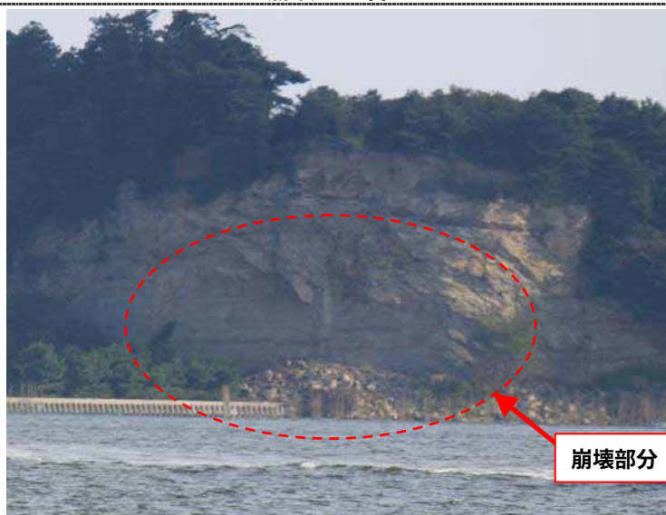
崩壊部の拡大写真
