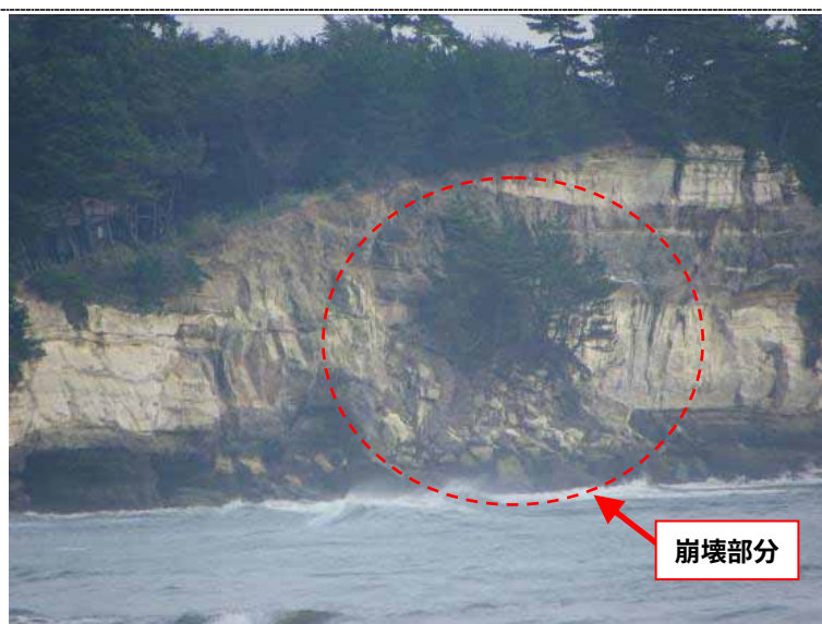
崩壊部の拡大写真
