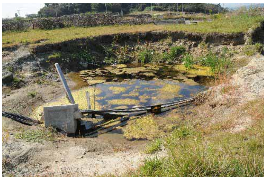
地面がえぐられた跡
