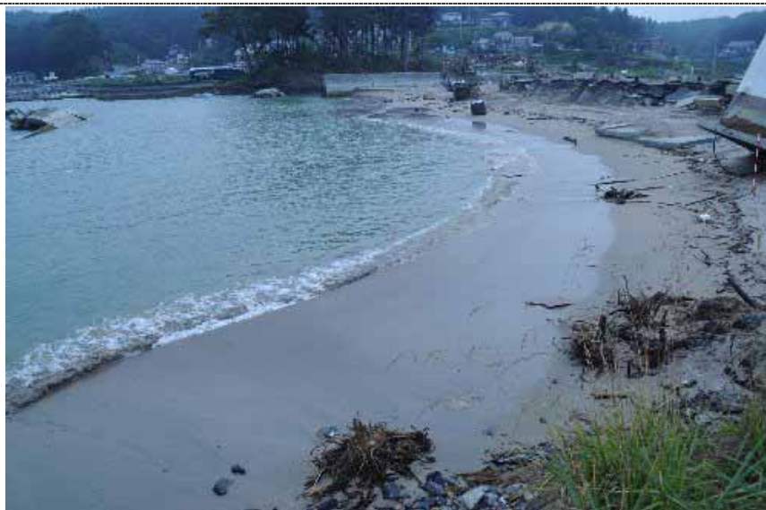
面積が減少した砂浜（画面右上の傾いた建物が海水浴場のトイレ）
