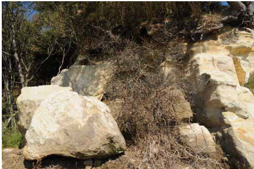
崩壊した斜面
