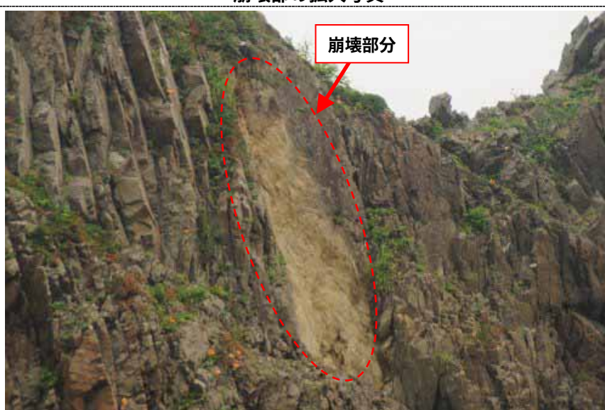
崩壊部の拡大写真
