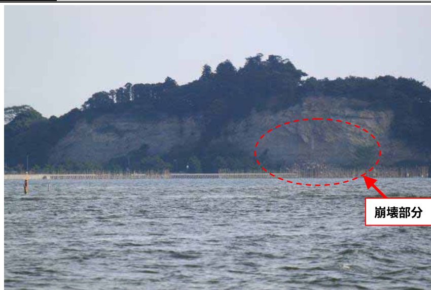
崩壊した岩壁
