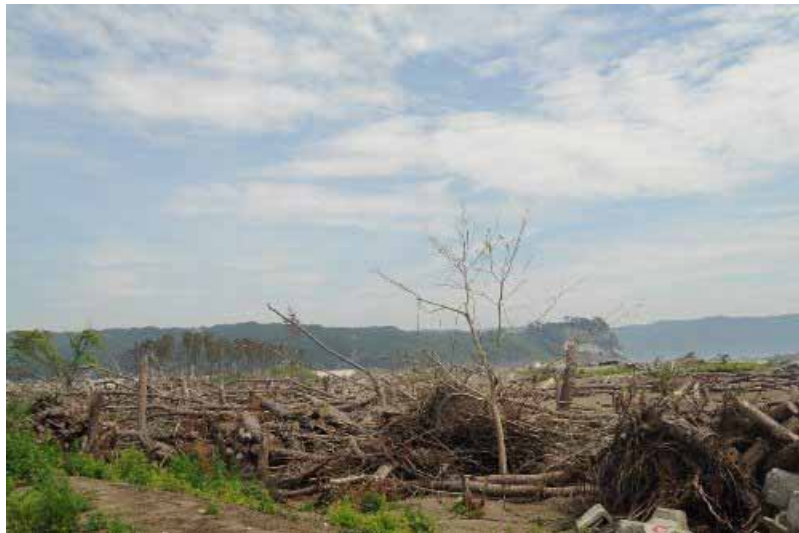
壊滅した堤防と松林
