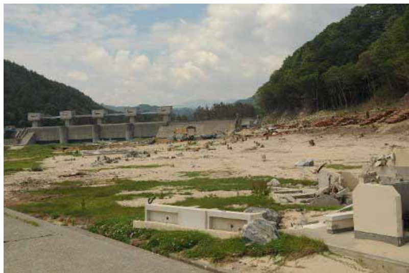
防潮林の跡地（防潮堤より下流側）
