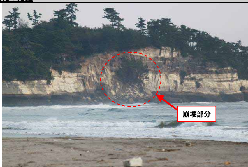
崩壊した岩壁
