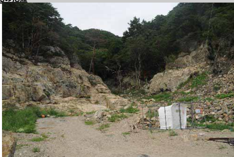
津波が遡上した谷部
