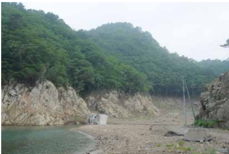
姉吉地区の海岸付近(斜面の植生が剥ぎ取られている)
