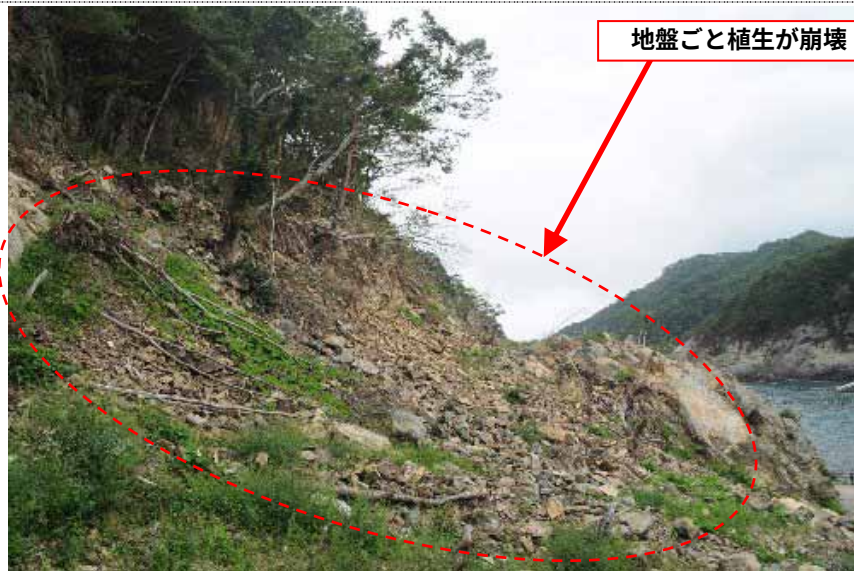
崩壊した斜面
