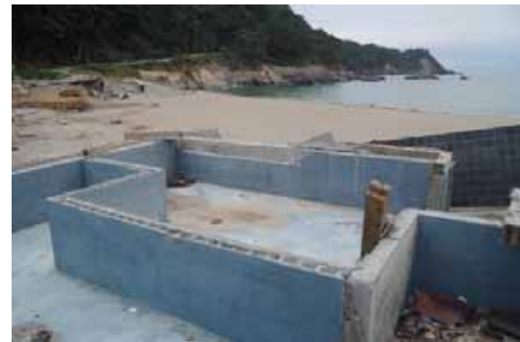
トイレ入口内部
