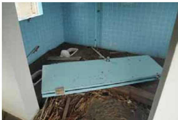
東側のトイレ内部
