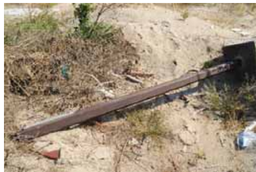
倒伏した支柱
