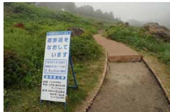
補修工事の様子
