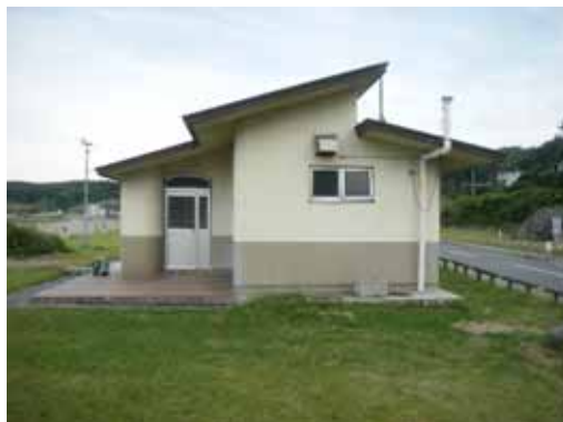
被災前 の白浜海水浴場公衆トイレ (写真：青森県提供)
