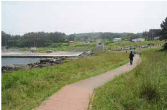
舗装部分及び階段部分
