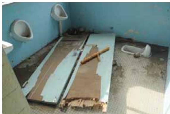
西側のトイレ内部の様子
