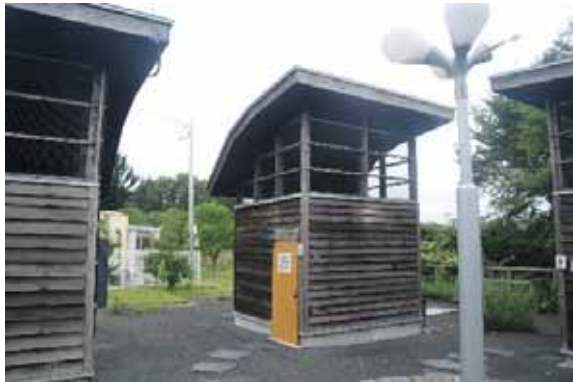
トイレ入口付近
