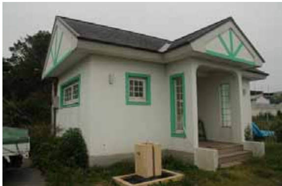
種差海浜公衆トイレ
