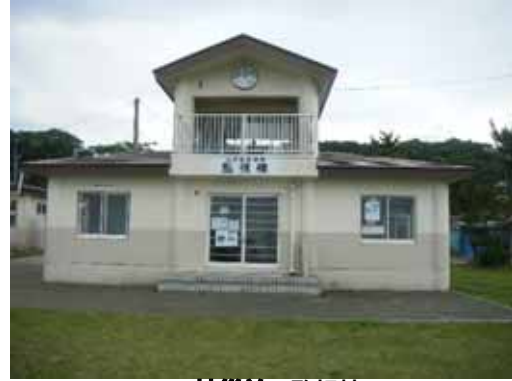
被災前の監視棟 (写真：青森県提供)
