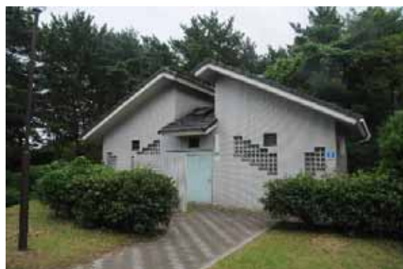
観光プラザ付近のトイレ
