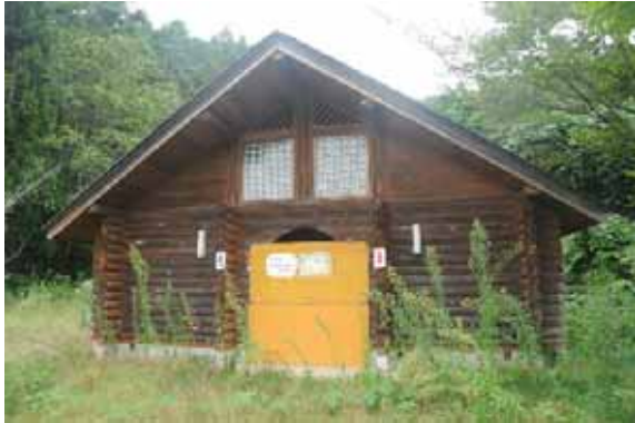
トイレ入口付近
