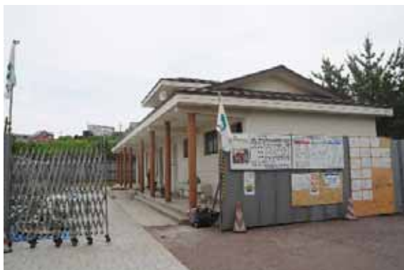
全景（修復工事中）
