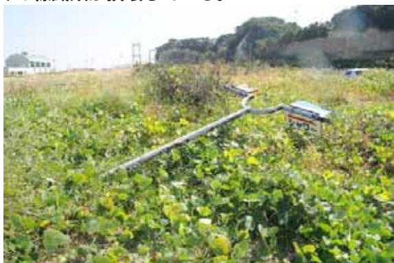
倒伏した案内標識
