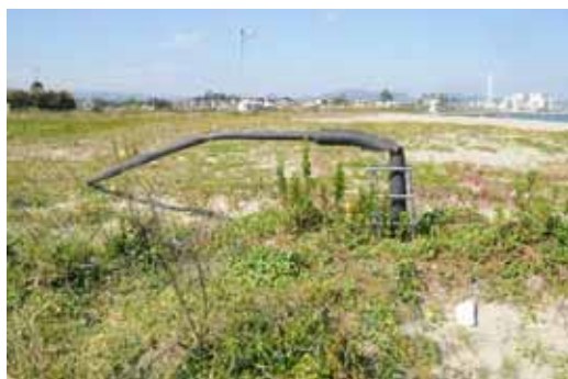
倒伏した支柱
