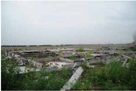
基礎のみが残された建造物跡
