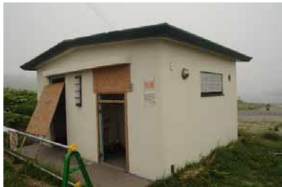
種差漁港公衆トイレ
