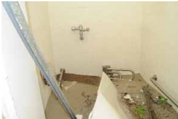
障害者用トイレ内部
