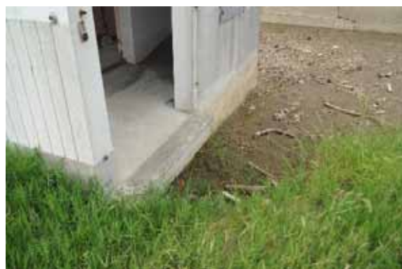
東側のトイレ基礎
