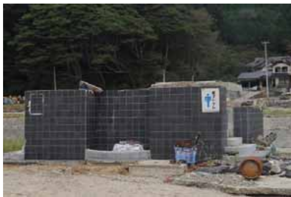
トイレ入口付近
