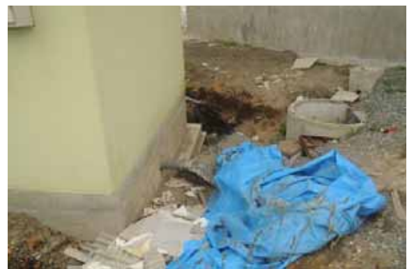
露出した基礎部分
