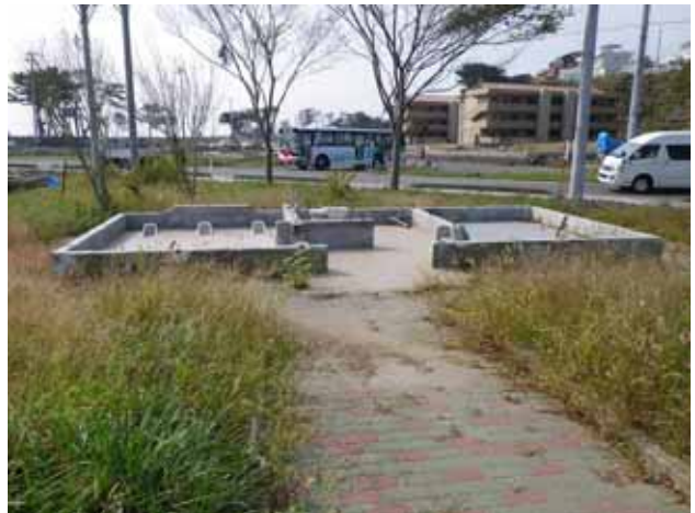
多目的広場のトイレ
