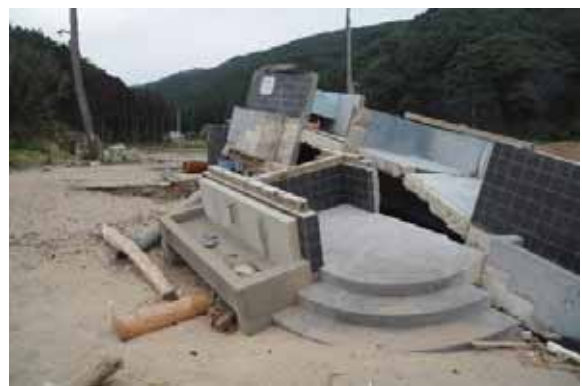
トイレ入口付近
