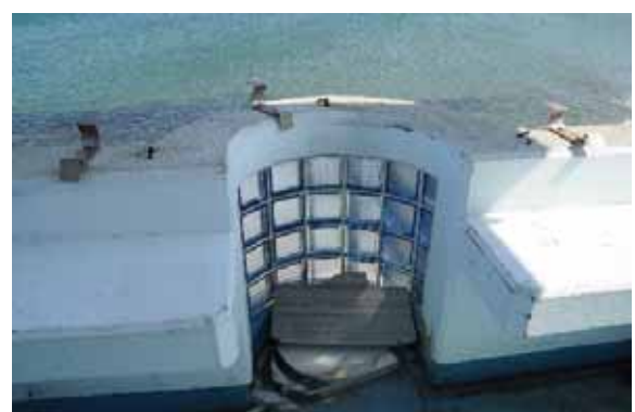
海側の手すり
