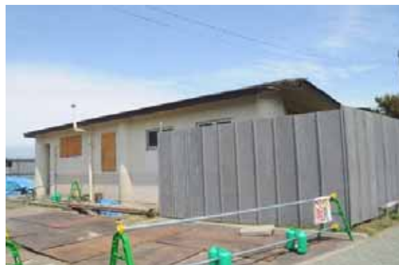
白浜海水浴場シャワー棟公衆トイレ
