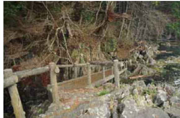
岩礁部の歩道（コンクリート製の橋梁）
