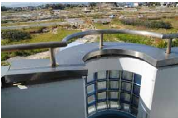
内陸側の手すり
