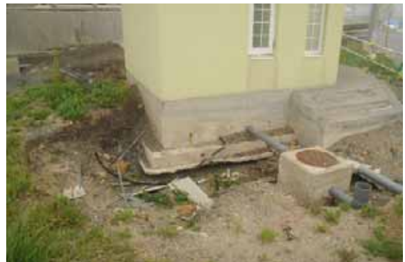
露出した基礎部分
