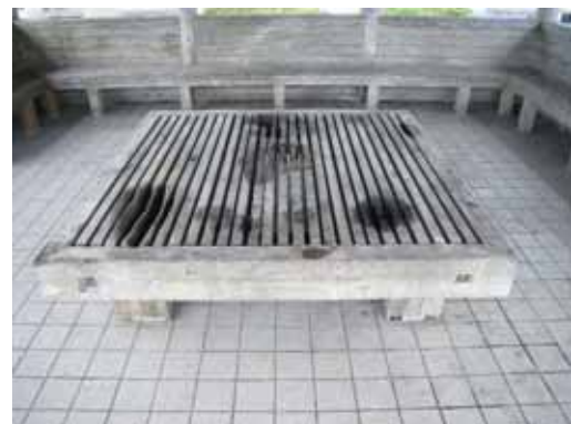
被災前の東屋内部 (写真：青森県提供)
