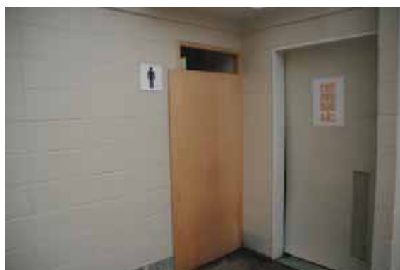
入口には板が打ち付けられている
