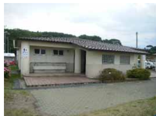
被災前 の白浜海水浴場シャワー棟公衆トイレ (写真：青森県提供)
