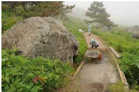
補修工事の様子
