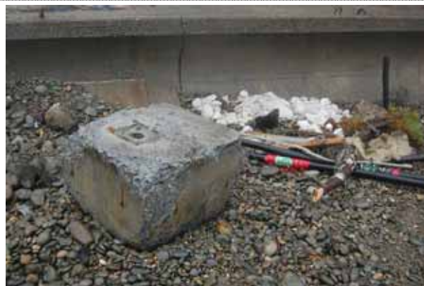
コンクリート片
