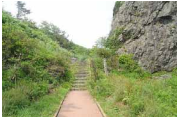
舗装部分及び階段部分
