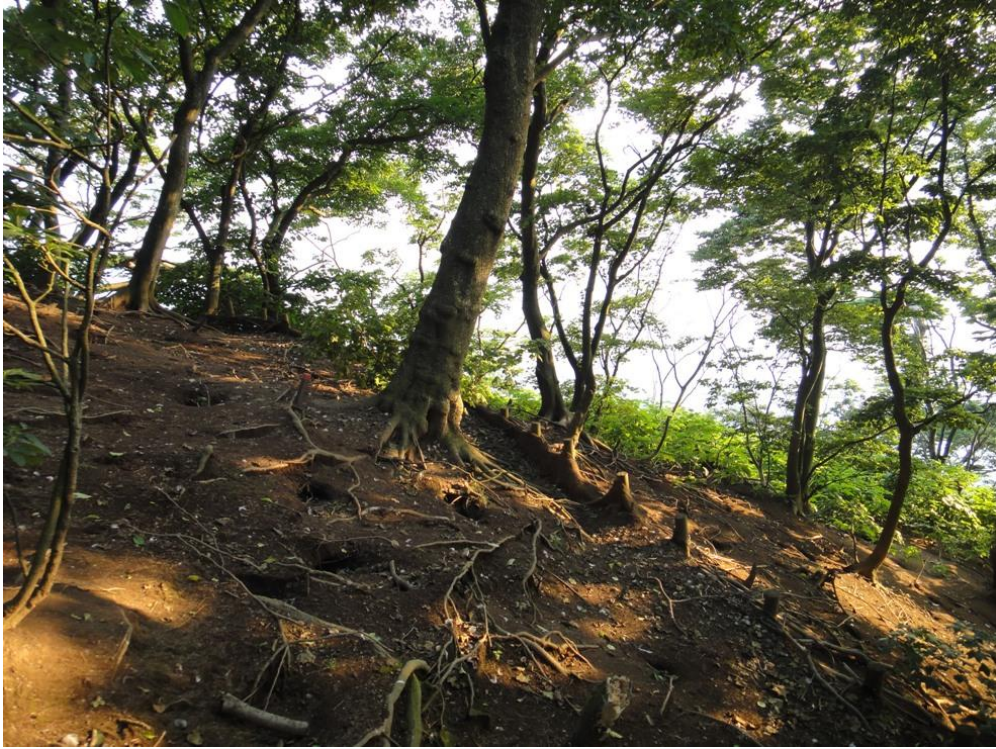
写真2-3-3 日出島 土壌流出により露出した樹木の根 (2010/8/6)
