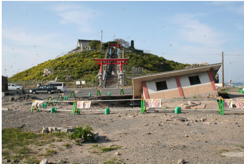
写真 4-3-1 蕪島, 手前は地震により倒れた公衆便所 (2011年6月3日)
